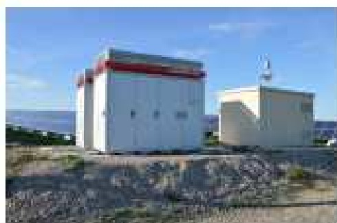
Photo 47 : Exemple d'onduleur Outdoor (source : QUADRAN)
