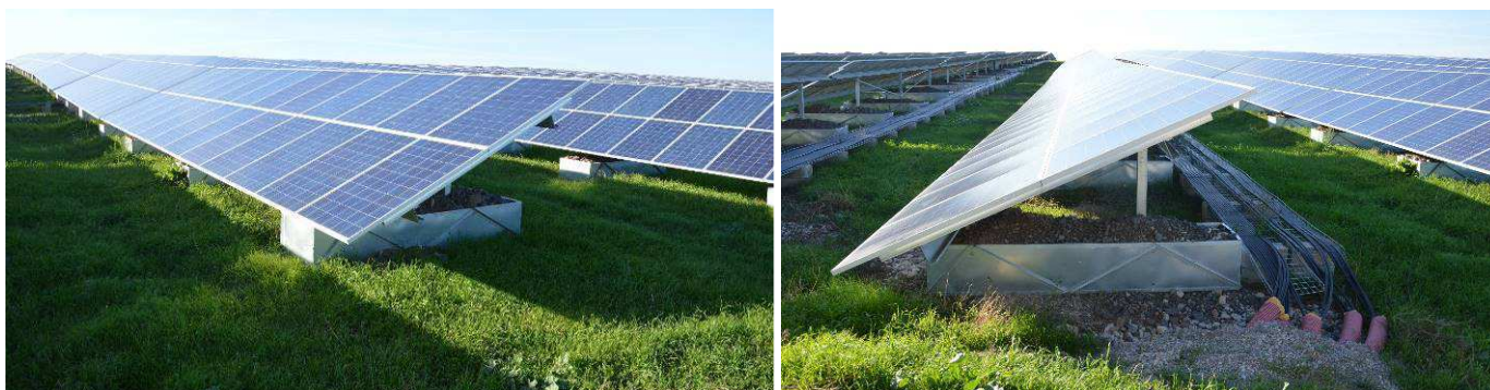
Photo 43 : Vues sur des longrines en gabion (source : QUADRAN, CET Saint-Jean-de-Libon, Hérault)
