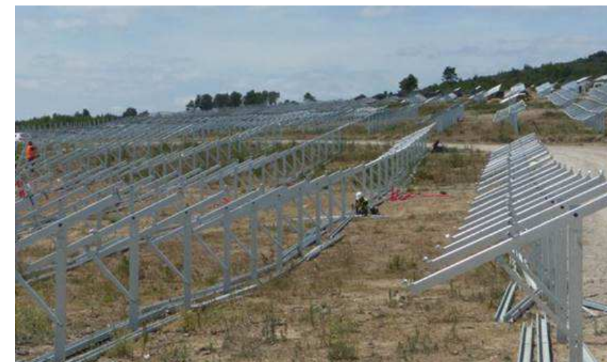
Photo 45 : Exemple de pieux creux (source : QUADRAN)
