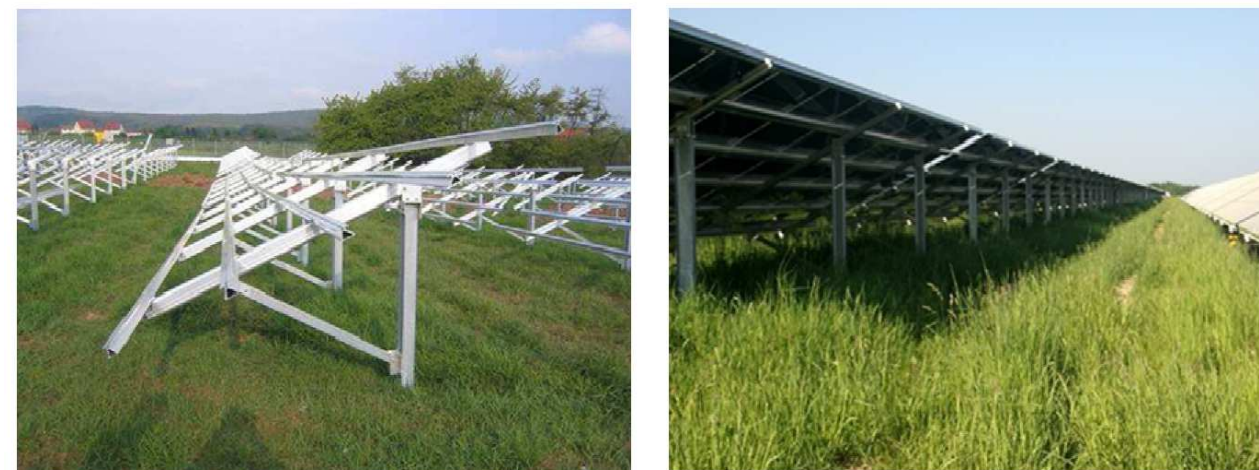
Photo 42 : Vues de la structure métallique avant et après assemblage des panneaux
